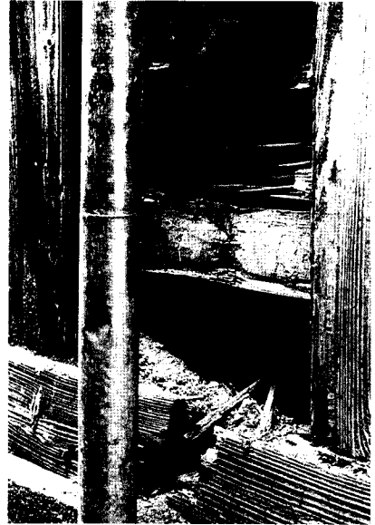
写6-1 老朽化著しい校舎 土台ならびにスキ、スノコが全部腐 蝕して、柱が下がっている。
