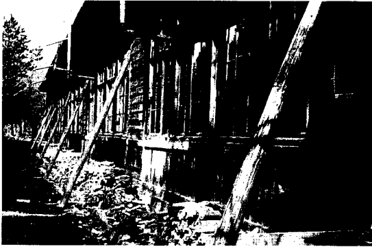
写6-2 左側に3寸程かたむいた校舎。 支えがしてある。
