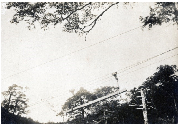
索道写真② 砥沢索道
