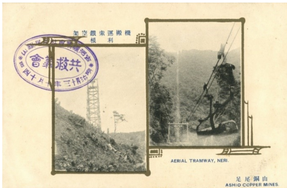
写真4 足尾銅山絵葉書 架空鉄索運搬機 根利
